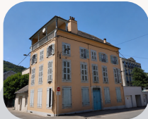
2- PRESBYTÈRE Bagnères-de-Bigorre Acquisition et réhabilitation du presbytère et des salles paroissiales.
