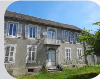
5- MAISON JEANNE D'ARC Arreau Réfection de la toiture et réhabilitation d'un appartement.
